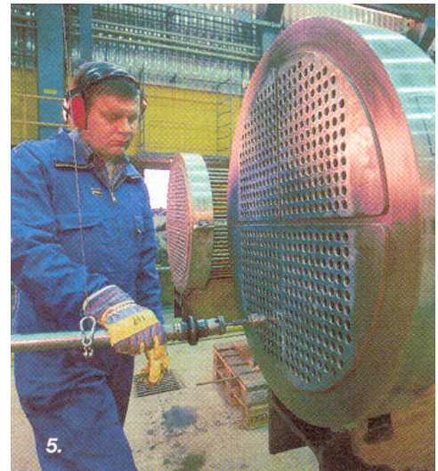
Invalsning av tuber med utrustning med momentkontroll
