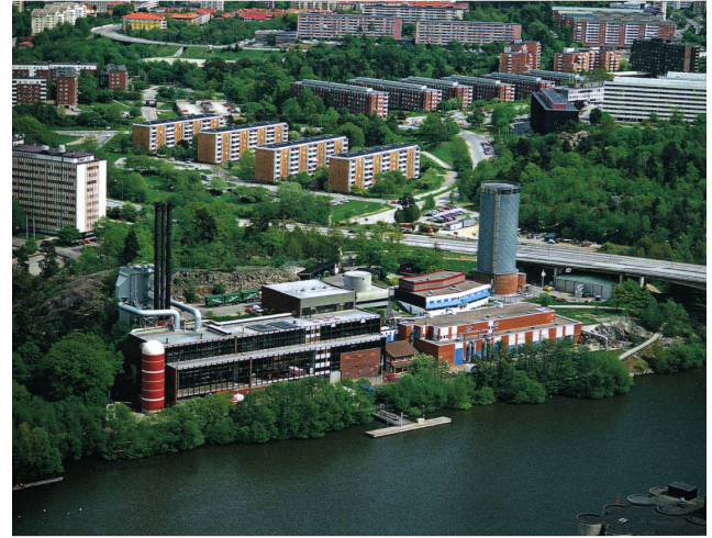
Norrenergi i Solna; Stora omtubningar med kamtuber utfördes sommaren 2004 och 2005
