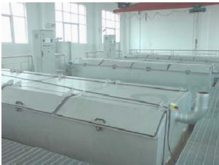
3 st Slasken SF 120 trumförtjockare installerade i ett större reningsverk i Louyang Chandong, Kina Den totala kapaciteten är 360 kbm/tim tunnslam
