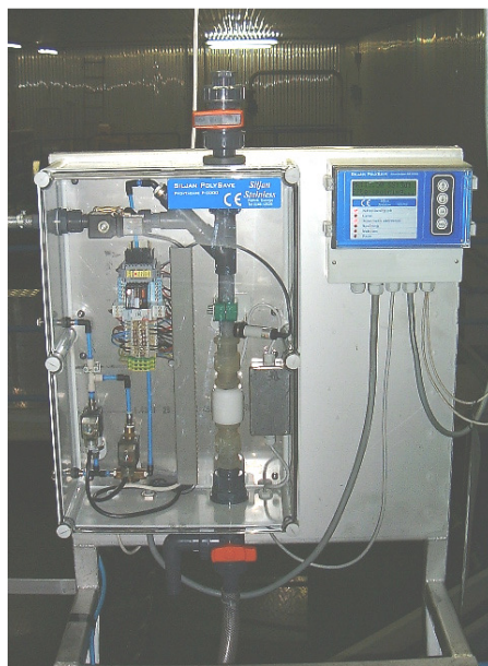
Bild av mät- och styrsystemet Siljan PolySave, med provtagaren, inklusive givare, till vänster och dator-enhet/styrbox till höger.
