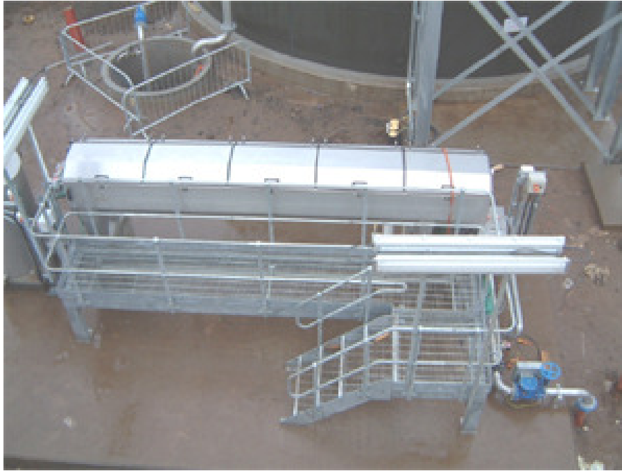
En trumförtjockare, Slasken SF 35, installerad i ett reningsverk i Bonnybridge i Skottland.
